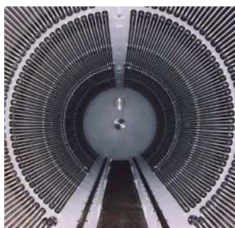
▲真空含浸槽 (内部)
